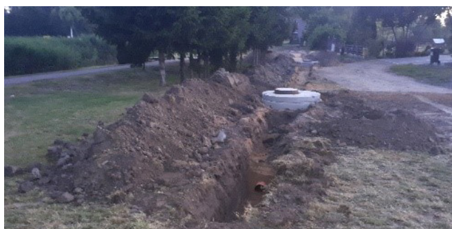
Budowa kanalizacji sanitarnej w ul. Wczasowej
