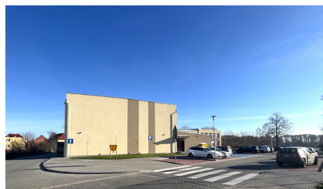
Przebudowa drogi na ulicy Żeromskiego w Drawnie
