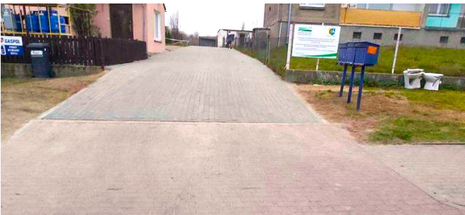
Przebudowa drogi wewnętrznej w Święciechowie
