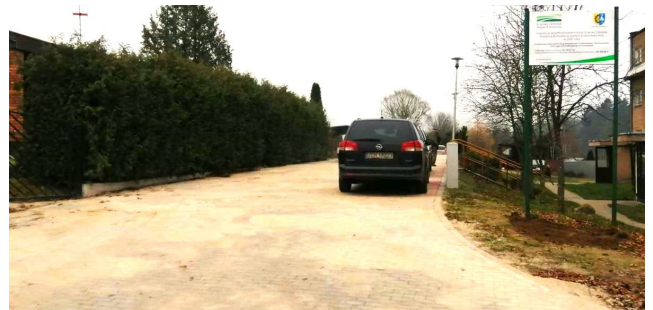
Przebudowa drogi wewnętrznej w Niemieńsku
