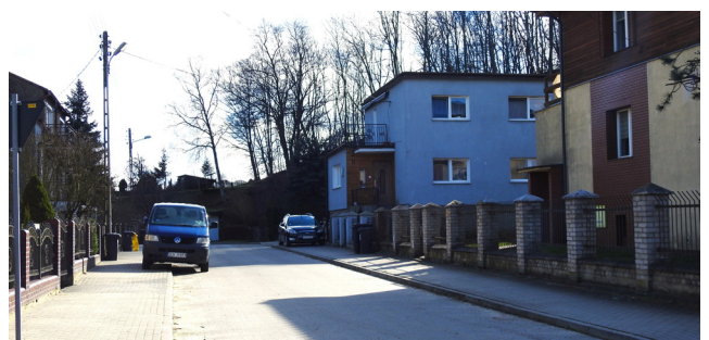
Przebudowa drogi wewnętrznej ul. Słonecznej w Drawnie
