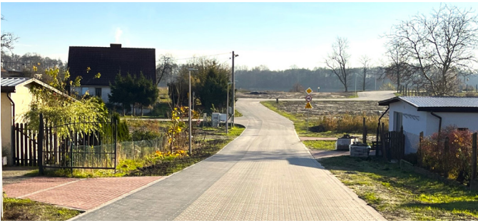
Przebudowa drogi na ulicy Wczasowej w Drawnie
