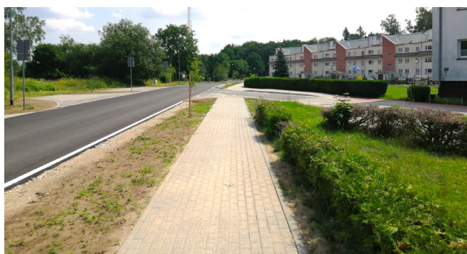
Przebudowa i budowa drogi gminnej Drawno-Zdanów
