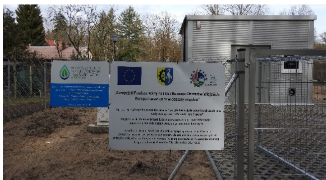
Budowa ujęcia wody w miejscowości Borowiec
