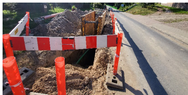
Budowa kanalizacji sanitarnej Barnimie - Drawno
