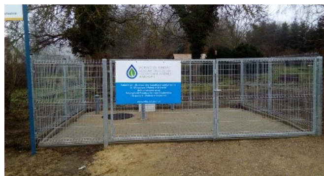
Budowa kanalizacji sanitarnej w ul. Polnej
