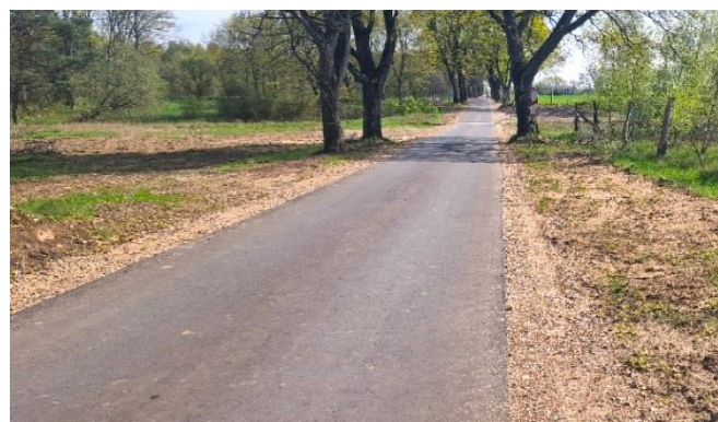
Przebudowa drogi do Sieniawy
