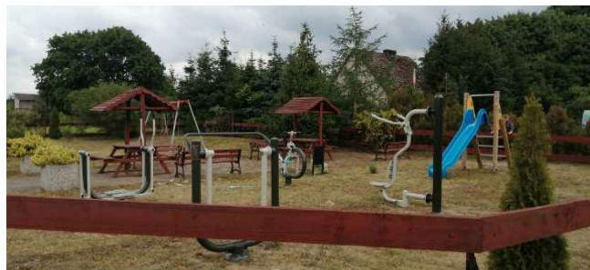
Montaż siłowni zewnętrznych: Podlesie, Barnimie i Kiełpino
