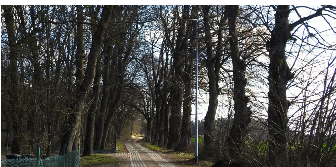
Budowa oświetlenia drogi gminnej w Sieniawie
