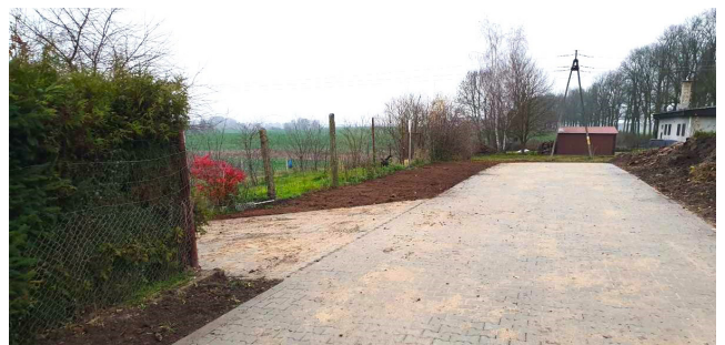
Przebudowa drogi wewnętrznej w Podegrodziu
