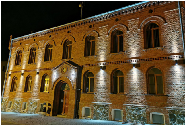
Remont budynku Urzędu Miejskiego w Drawnie
