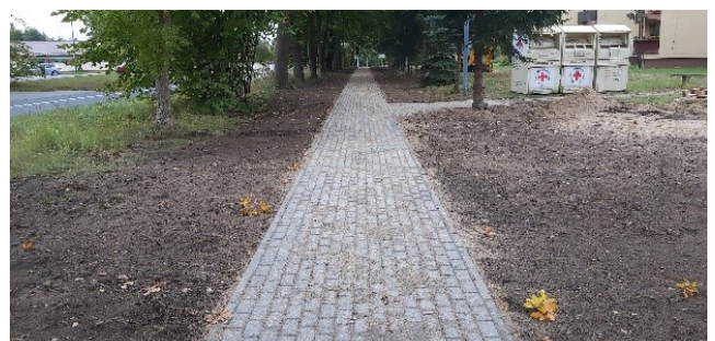
Budowa chodnika przy ul. Kaliskiej w Drawnie
