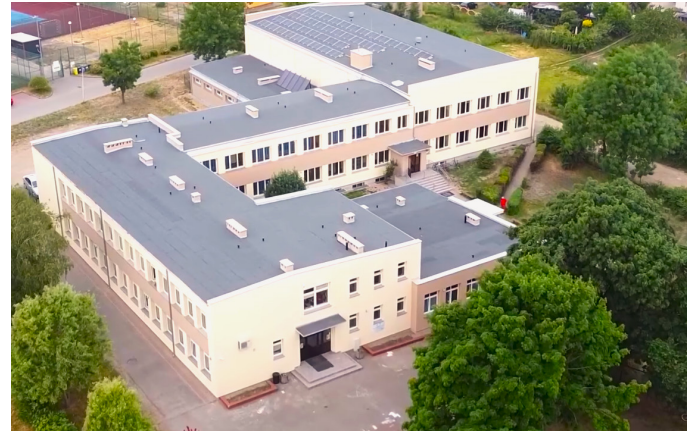
Remont szkoły i przedszkola
