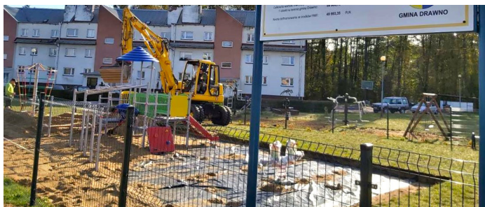
Budowa placu zabaw na ul. Leśników w Drawnie
