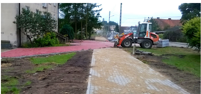
Budowa chodnika w Święciechowie
