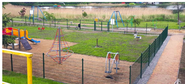
Budowa placu zabaw na ul. Kolejowej i siłowni plenerowej
