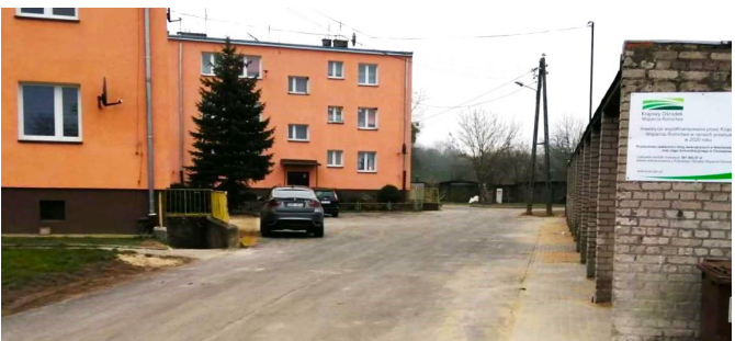
Przebudowa ciągu komunikacyjnego w Chomętowie
