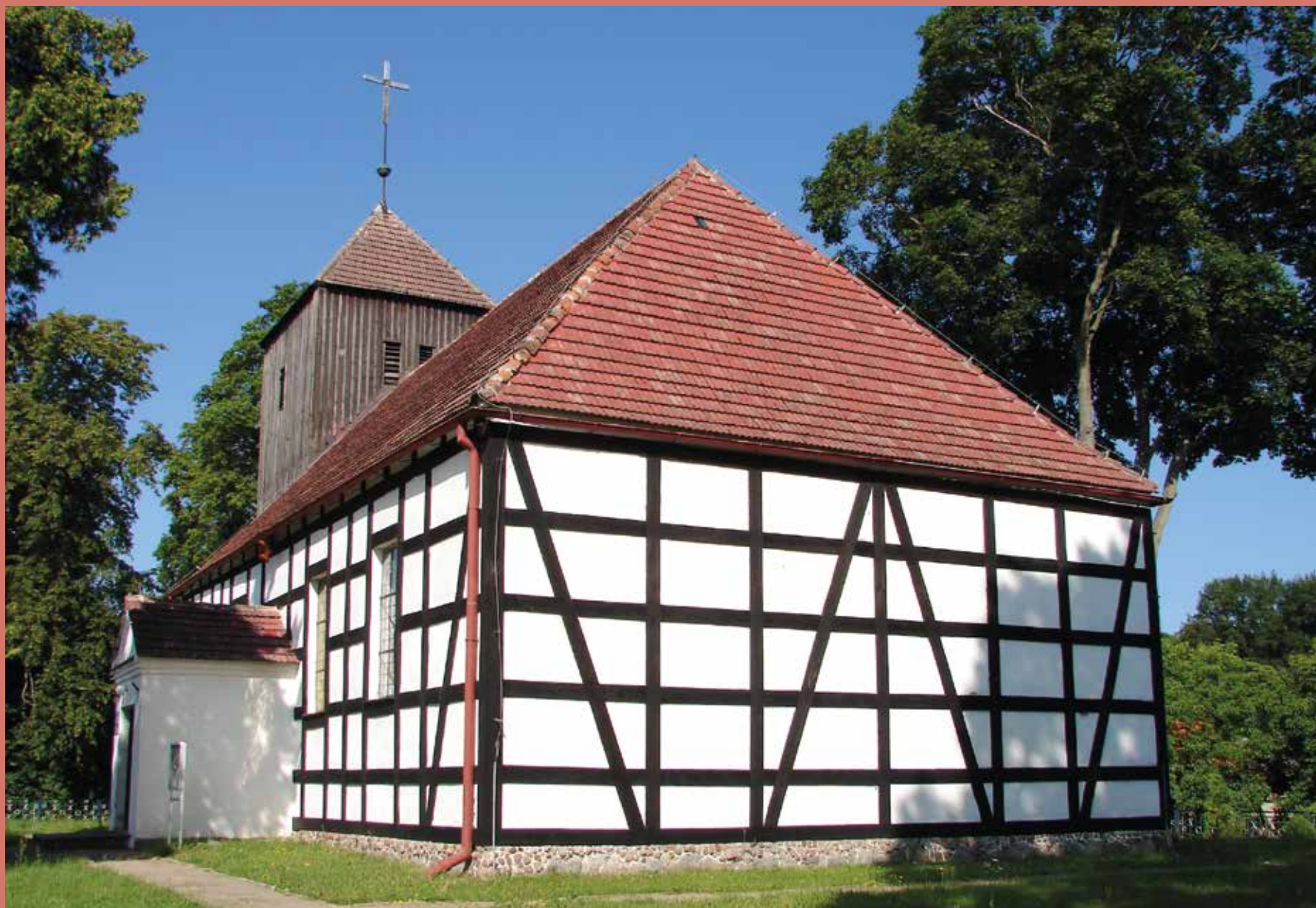
▲ Brzeziny, kościół pw. Nawiedzenia Najświętszej Maryi Panny z 1756 r., o konstrukcji szachulcowej, przebudowany w 1967 r.
