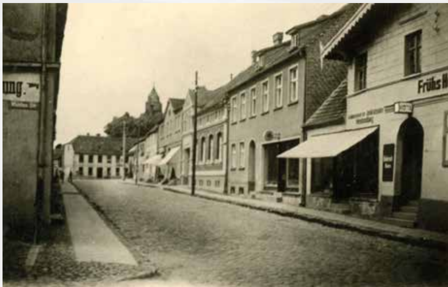
▲ Drawno, ul. Kolejowa (Neue Strasse) w kierunku Placu Wolności i kościoła
