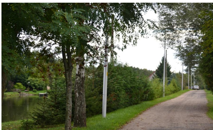
Oświetlenie na ul. Młyńskiej w Dominikowie
