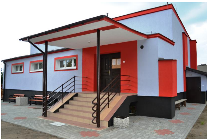
Świetlica wiejska w Barnimiu
