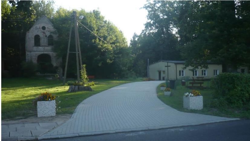
Świetlica wiejska w Chomętowie wraz z dojazdem
