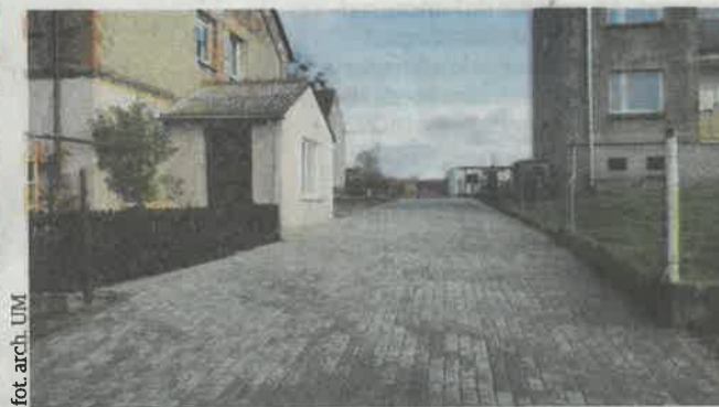
Świąciechów, przebudowa drogi wewnętrznej.
