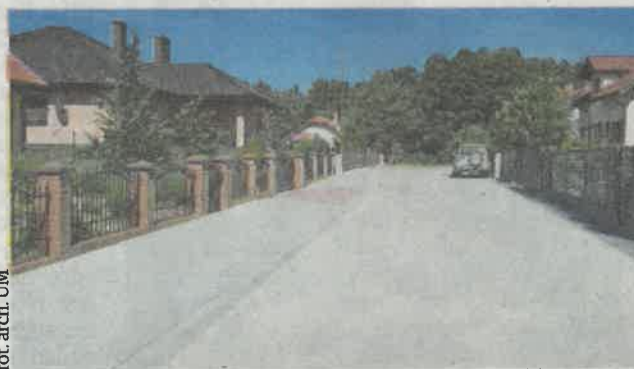
Drawno, przebudowa drogi wraz z infrastrukturą na osiedlu-ul. Potokowa.
